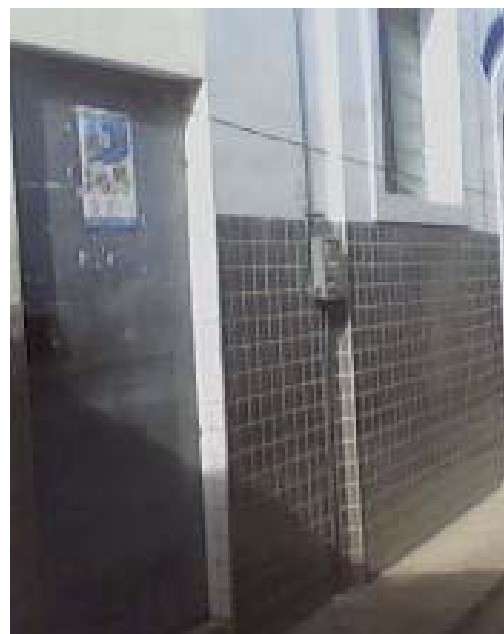
FIGURA 6 – fachada da escola
