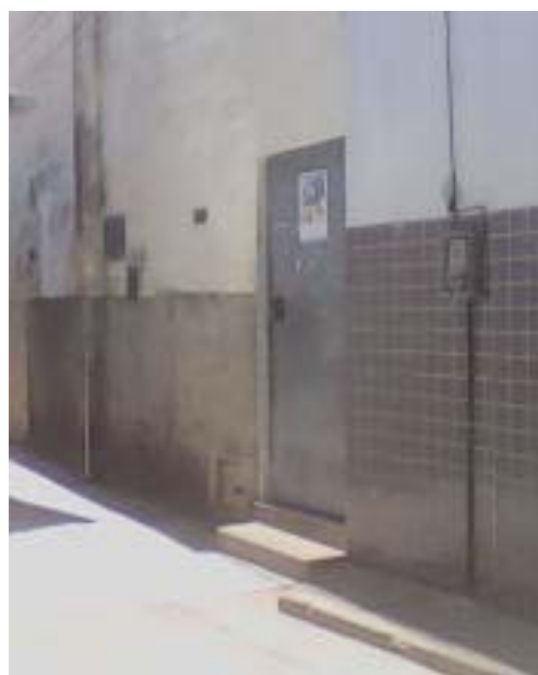
FIGURA 8 – fachada da escola
