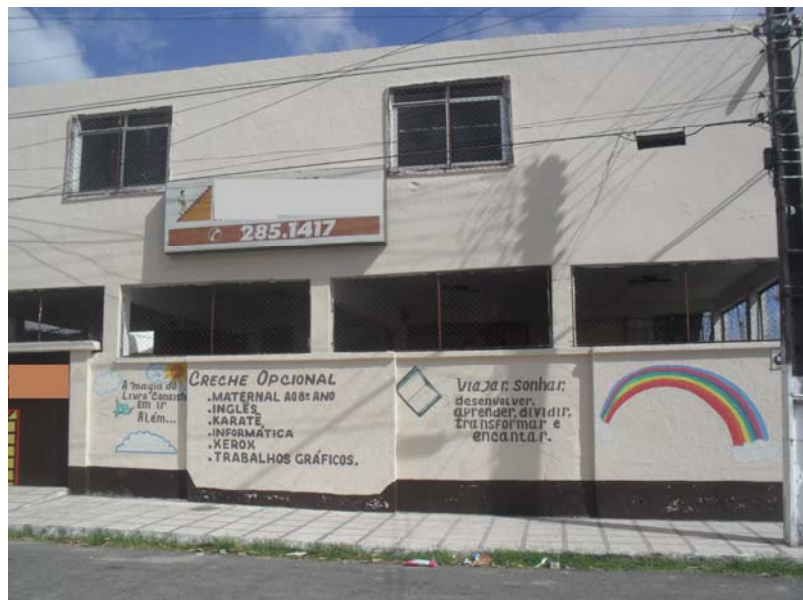
FIGURA 12 – fachada da escola
