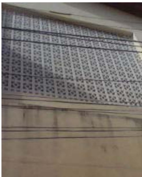
FIGURA 7 – fachada da escola
